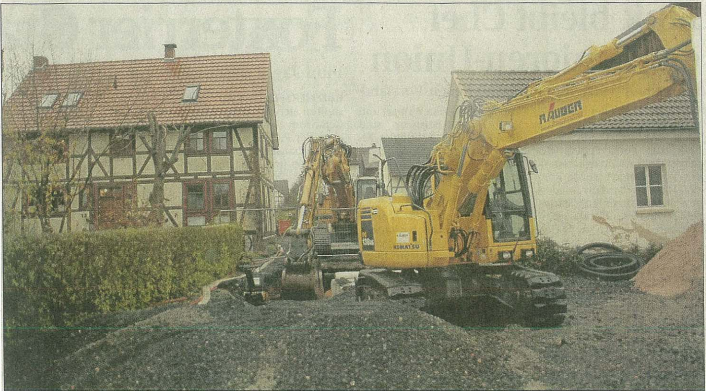
Im Taktverfahren graben sich die Arbeiter der Baufirma Räuber durch den ins Unterirdische verlegten Verlauf des Asbaches. Foto: Hornickel
