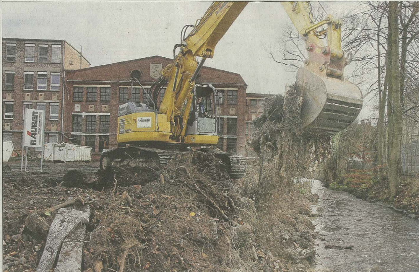
Elmar Spies langt in seinem Bagger mächtig zu. Vor der zukünftigen Veranstaltungshalle auf dem ehemaligen Grenzebach-Areal (hinten) legt er einen natürlichen Flusslauf aus Menschenhand an.
