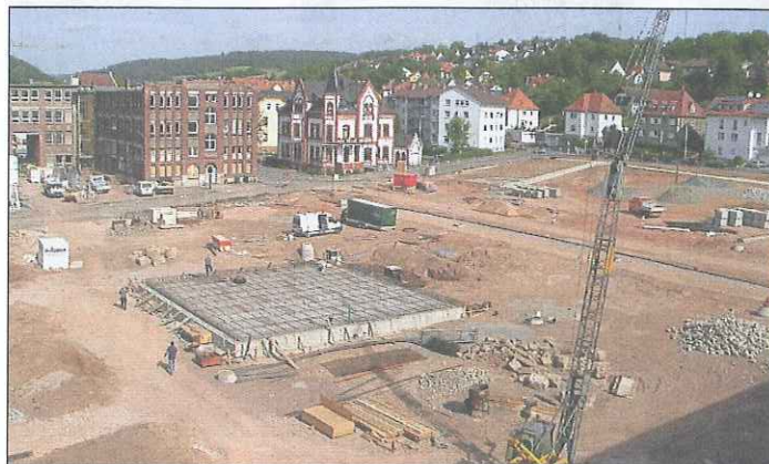
„Schildepark“ im Bau. Das Unternehmen Räuber GmbH war maßgeblich mit der Realisierung beauftragt. Fotos: privat
