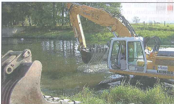
Auch an der Renaturierung der Wohra bei Kirchhain war das Bauunternehmen Räuber GmbH beteiligt.
